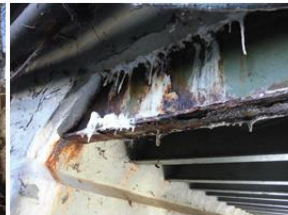
HP2016_LÄNGSTRÄGER KORRODIERT [3] S=0, V=0, D=2 BSP-ID 002-12 Platte, Beton, Bereichsweise, Durchfeuchtet mit Ausblühungen / Aussinterungen, Oberstromig
