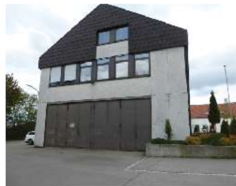
Abb. 49: Derzeitiges Feuerwehrhaus im Gebäude des Rathauses
