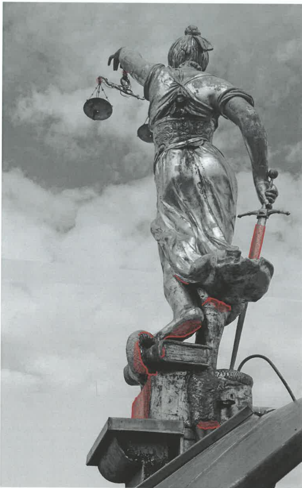
rote Linien: Risse; rot gesprenkelt: gelockerte Bereiche, Klaffungen
